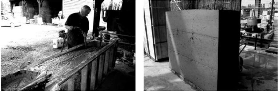
**Figure 2a et 2b** La découverte des empilements de grains permet aujourd'hui de couler une terre naturelle comme un béton, en utilisant les principes utilisés pour formuler des bétons fluides dits autonivelants ou autoplaçants.
