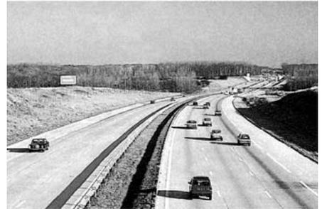
Figures 8 Deux exemples illustrant l'énorme impact environnemental que peut avoir, lorsqu'il est associé à une conception appropriée, un matériau de très grande durée de vie : 8a la Gare de Lyon, à Paris, construite en 1895, et qui répond toujours aux besoins d'aujourd'hui et 8b le réseau routier belge, construit à 90% en béton et dont la longévité en fait le réseau routier le moins cher du monde !
