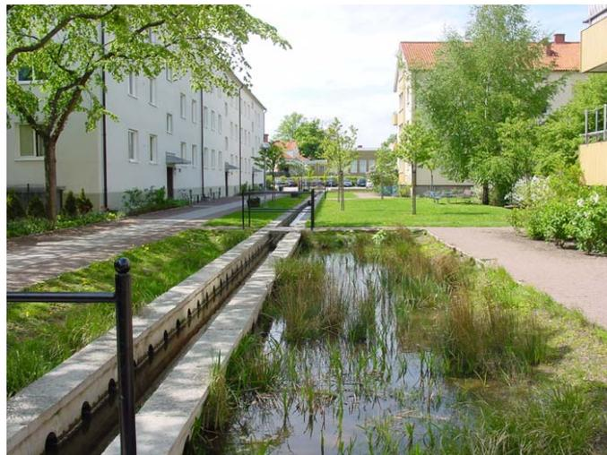
Fig. 171. Sistema de jardines de lluvia con sistema de fitoremediación de aguas grises.
