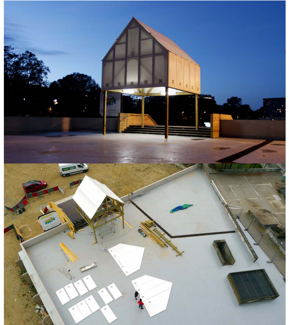
Plateforme publique au Mirail - Toulouse
