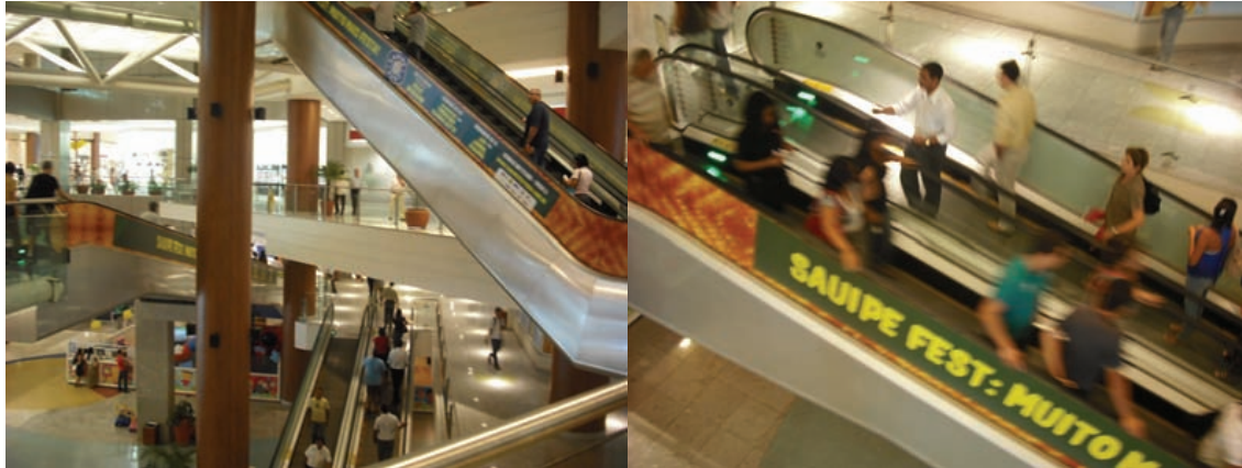
Rampes et escaliers mécaniques (photos SB)
