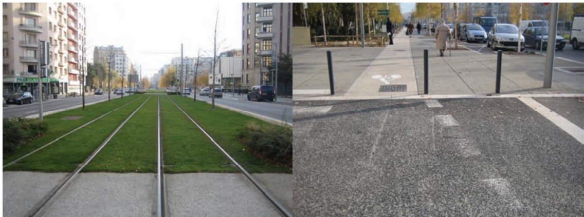
Étanchéification et canalisation des flux (photos RT)
