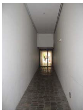
Couloir-sas d'entrée couvert logement
