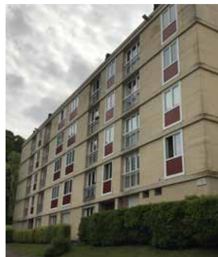
Construction en béton des années 60
