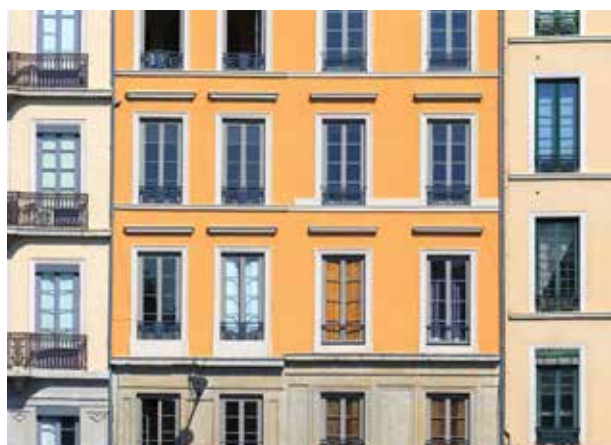
Construction en pierre
