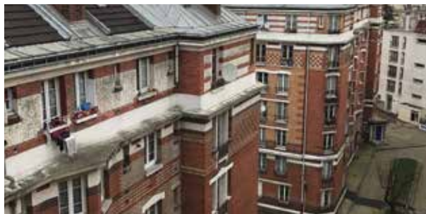
HBM Façades en briques
