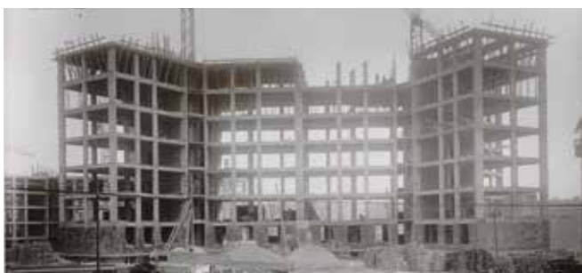
HBM Structure poteaux-poutres en béton
