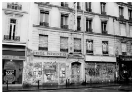
2 - Quartier en rénovation - 91 rue Oberkampf
