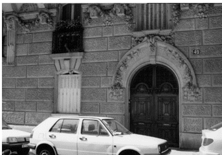
17 - Rue Decamps, immeuble aux têtes de bélier
