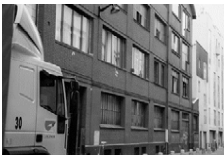
13 - Entreprise (fabrique de cartons) Cité Griset
