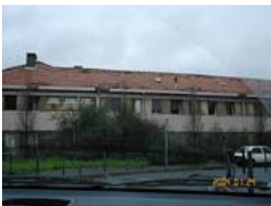
Le bâtiment de l'AFPA endommagé
